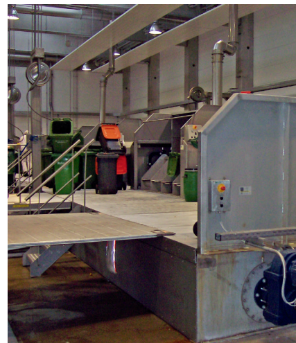
Plateforme de réception des conteneurs
